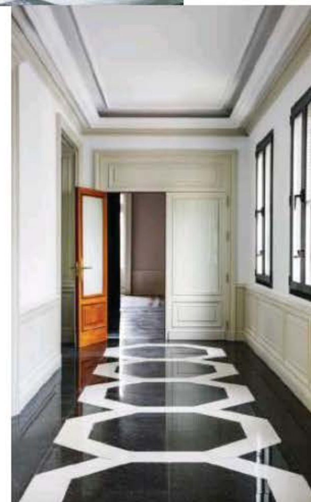
Caja clásica. Suelos de mármol, zócalos de madera... los espacios en su estado previo a la intervención de Cousi Interiorismo. Arriba, la estancia del lobby. Debajo, el pasillo que conducirá a él.
